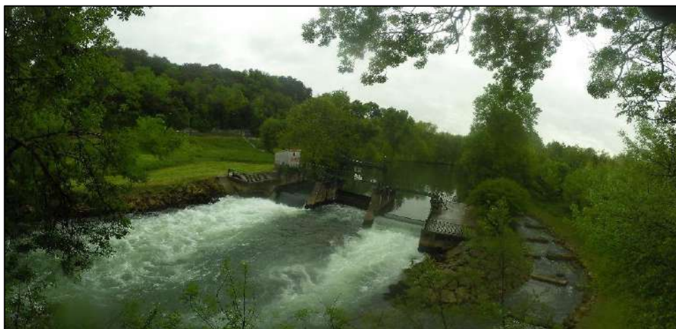
Figure 115 : Photo de l'ouvrage de Bagnolet le 19 avril à 8h30 (photo caméra Timelapse)
