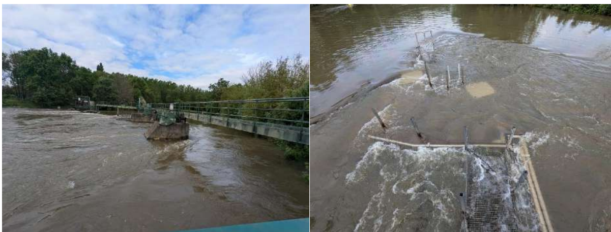
Figure 111 : Barrage de Crouin franchissable et passe-à-poissons sous l'eau le 24 avril 2025 (Photos François ALBERT – MIGADO)
