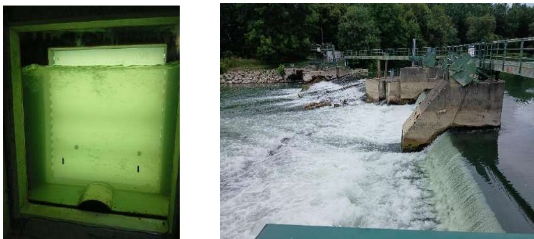
Figure 18 : Vitre de comptage (06/03/2025) et barrage de Crouin (26/06/2025)
