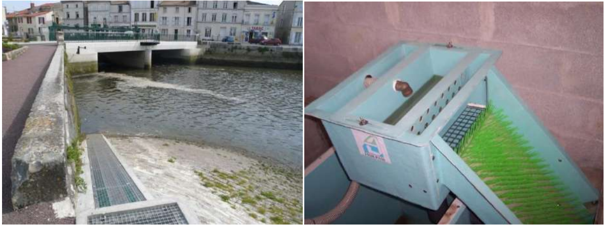
Figure 85: Photos de la passe piège anguilles de Saujon (brosse extérieure sous grille et piège)
