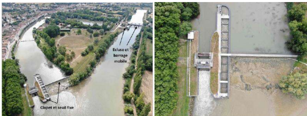
Figure 89 : Photos du complexe hydraulique de Saint-Savinien avec zoom sur le bras principal et les passes à poissons (photos MIGADO)
