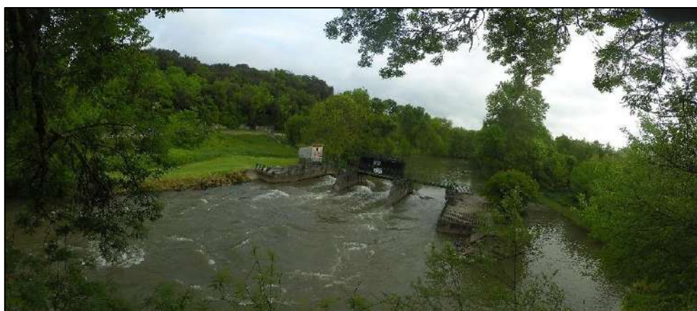
Figure 116 : Photo de l'ouvrage de Bagnolet le 22 avril (photo caméra Timelapse)
