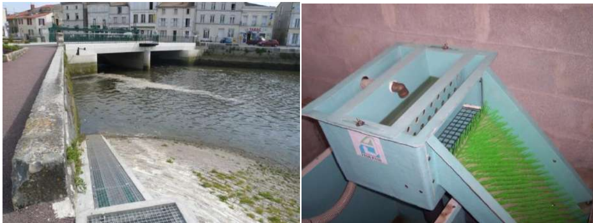
Figure 68: Photos de la passe piège anguilles de Saujon (brosse extérieure sous grille et piège)
