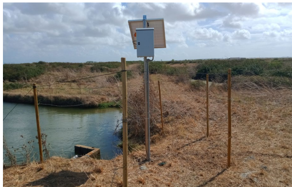
Coffret avec lecteur et antennes pour suivi marquage anguilles
