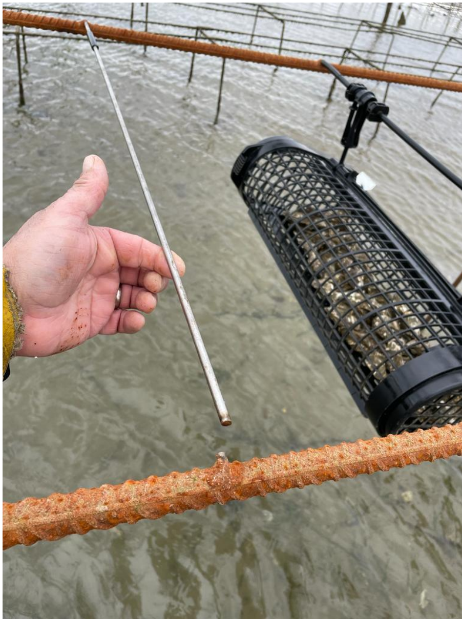
Figure 46 : Rupture d'une tige inox et chute du casier pendant un cycle d'élevage.
