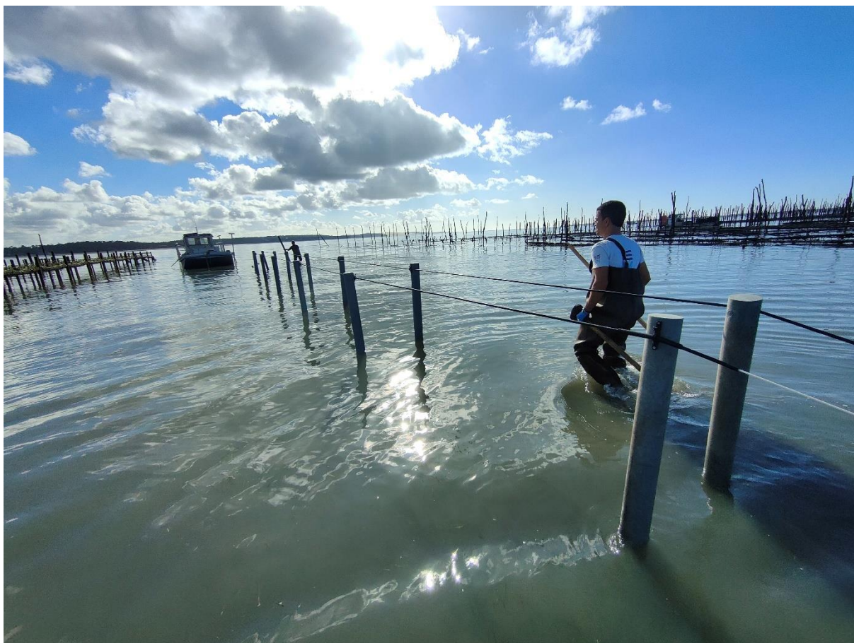
Figure 42 : Longline hissée et tendue sur l'ensemble des poteaux de ligne
