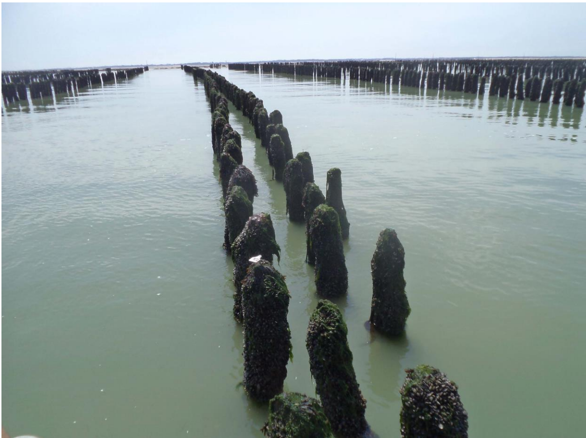
Figure 5 : Alignement de pieux doublés. Une marque de pieu témoin est visible.
